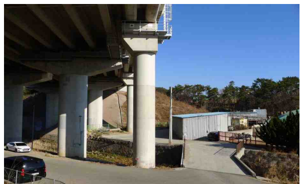
h. 교각 전경
