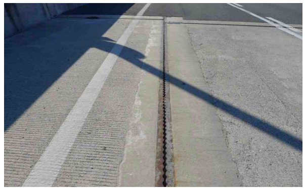
d. 신축이음(종방향) 전경
