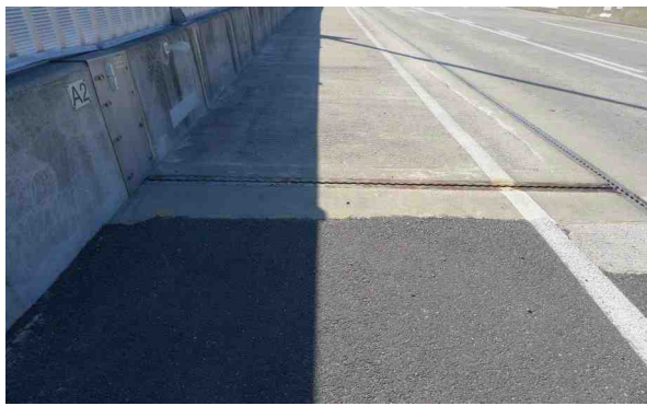
c. 신축이음(횡방향) 전경
