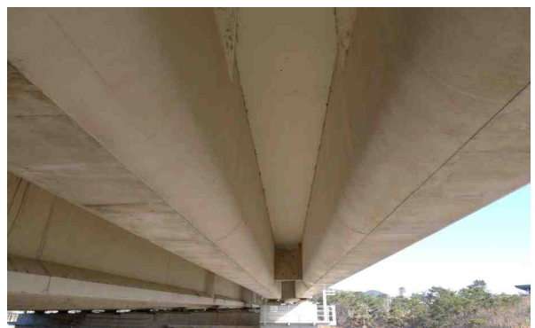
f. SB40 Girder 전경
